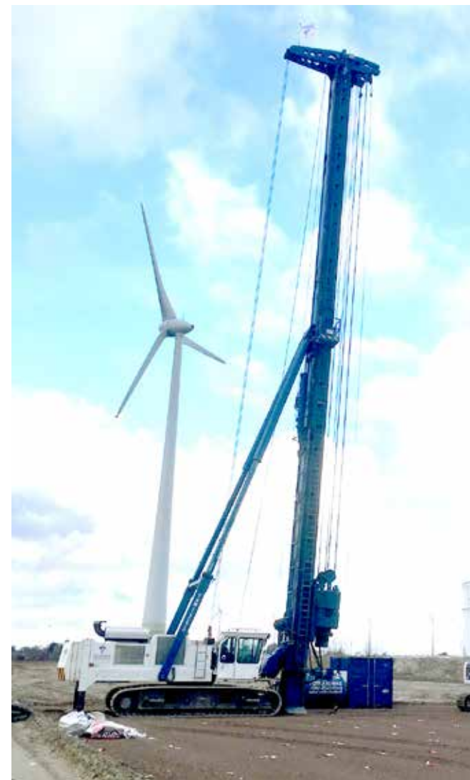
De fundering gebeurt door middel van grondverdringende schroefpalen.
